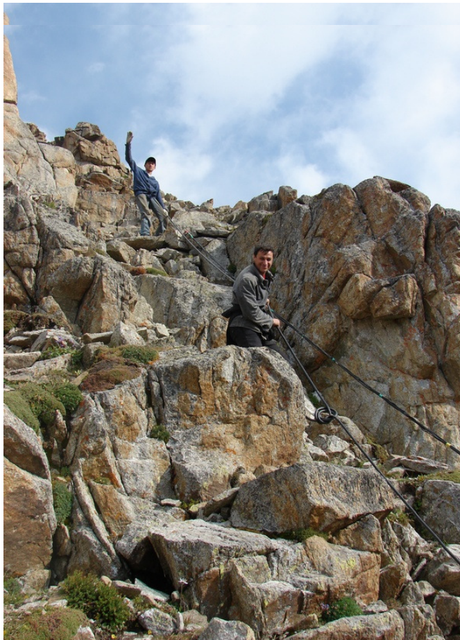
Подъем кабеля для верхнего детектора
