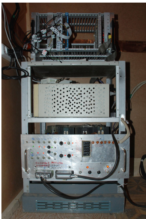
Стойка с блоками системы регистрации установки Хронотрон-8.
